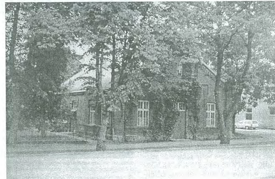
Omaaegse mootoritööstuse „Baltika“ hoone, praegu baptistide palvela Paides The building of the former motor industry „Baltika“, now a baptist church in Paide Здание завода по производству моторов, сейчас молельня баптистов в Паиде
